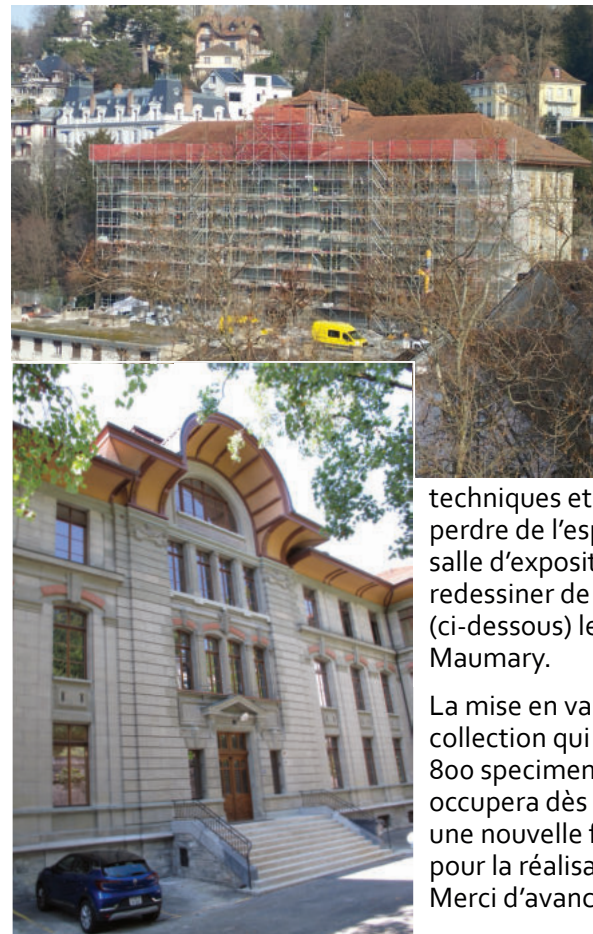
Ci-contre: Le collège de la Barre pendant et après les travaux, N. Demarta
