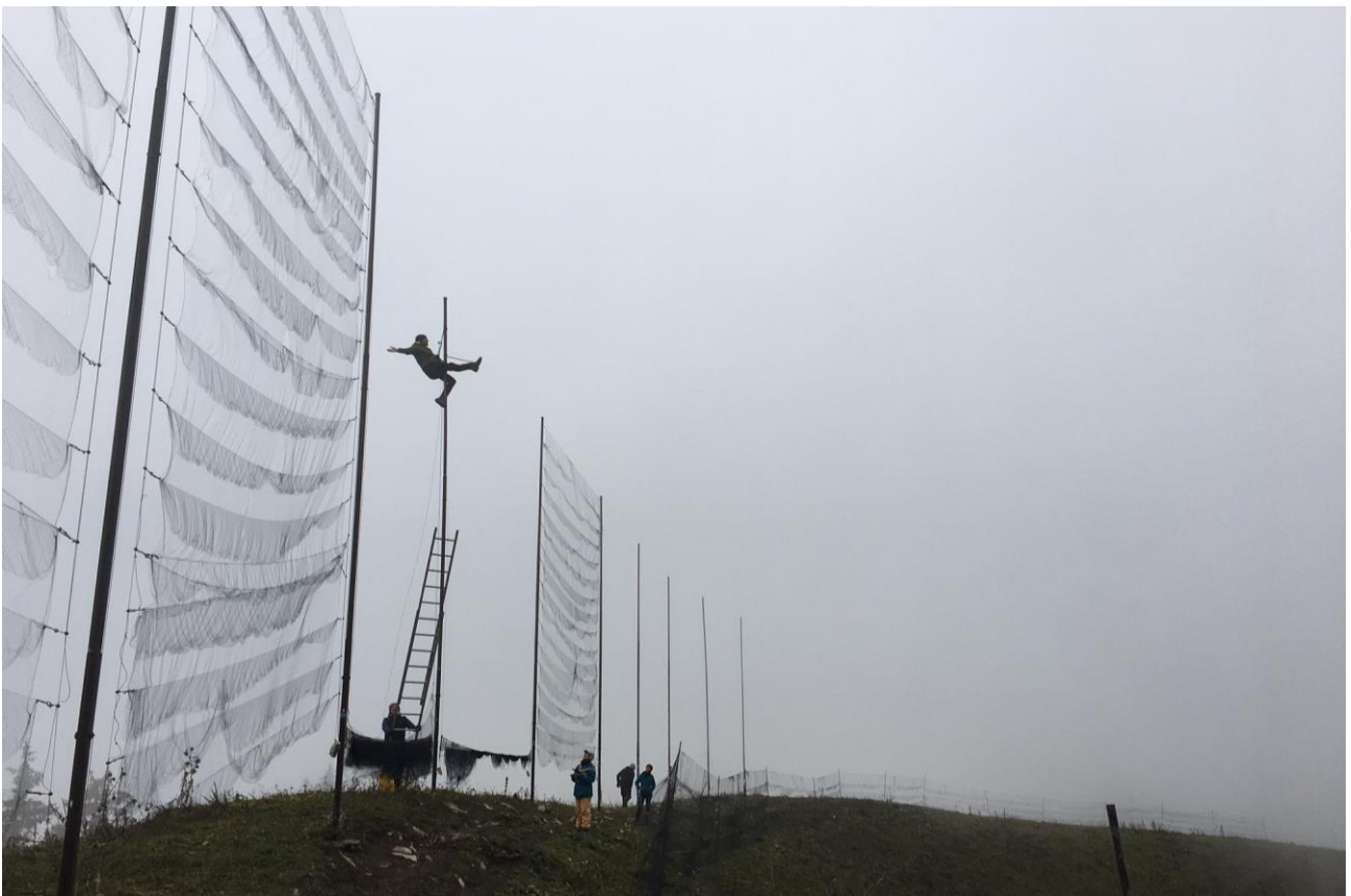
Le 17 octobre 2020, des réparations doivent être faites au sommet des perches entre les filets no 13 et 14. P. Bottin
